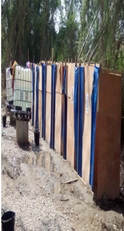
Foto 9: Lokasi MCK di Kuala Langsa, Aceh Timur (Foto: Komnas Perempuan)
